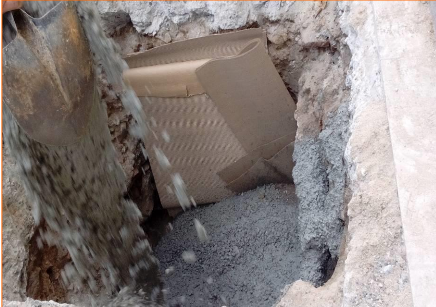
Foto 15. Rebliment amb formigó de les rases un cop protegida l'estructura UE 8 amb capes de geotèxtil recobert amb cartró.
