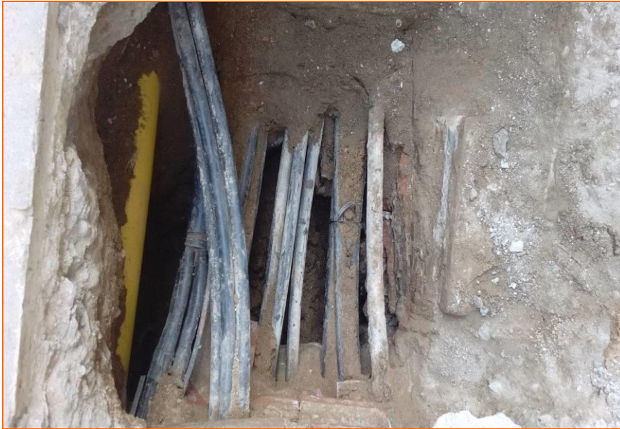
Foto 11. Procés d'excavació de la rasa amb presència dels serveis contemporanis.
