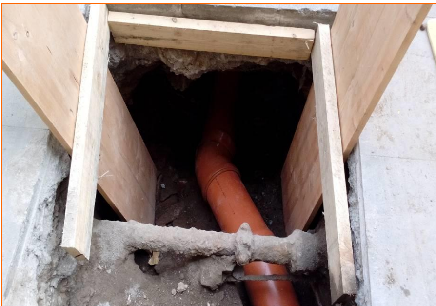
Foto 14. Instal·lació del nou tub de desguàs vers el col·lector principal.
