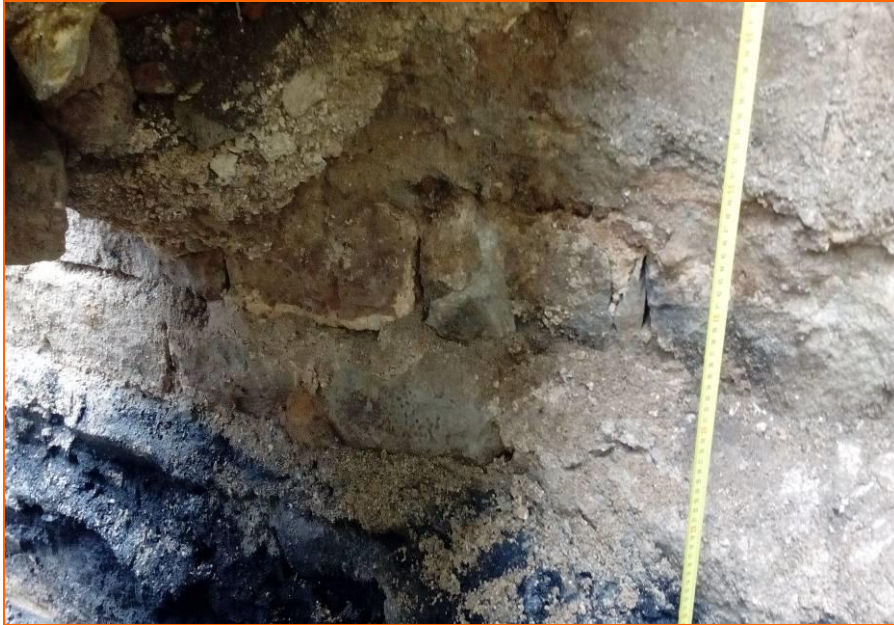
Foto 9. Continuació de l'alçat del mur UE 8.
