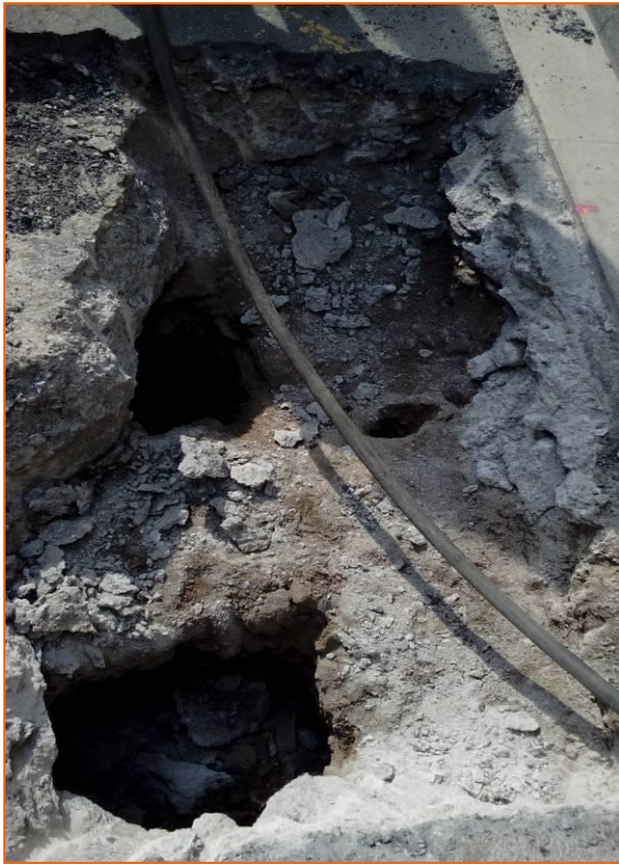
Foto 5. Retirada del paviment superficial i aparició de les sorres esllavissades UE 4.
